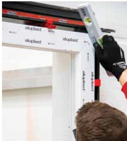
**13** Fenster vorbohren, einsetzen und ausrichten
