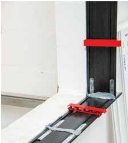
**12** Ecken abdichten und Federclipe positionieren
