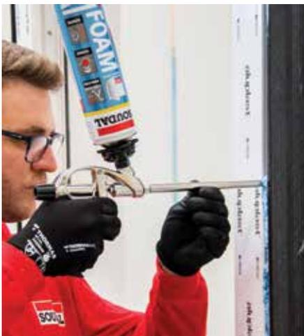
**15** Federclipe entfernen und Fenster abdichten
