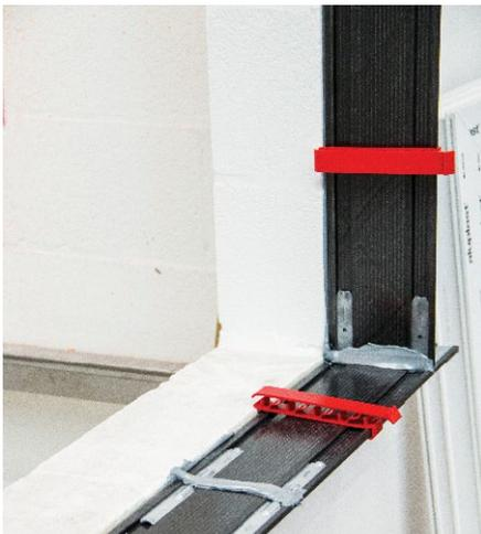
**12** Ecken abdichten und Federclipe positionieren
