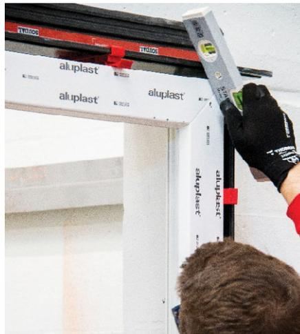
**13** Fenster vorbohren, einsetzen und ausrichten
