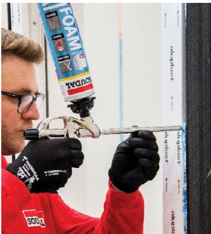
**15** Federclipe entfernen und Fenster abdichten
